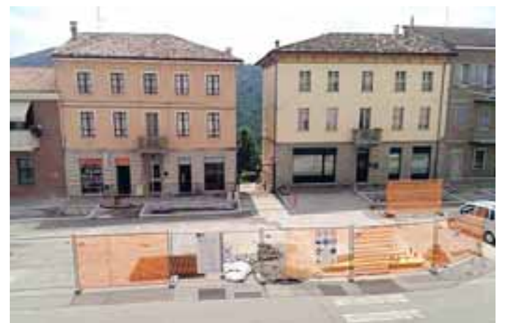
I lavori in corso per la riqualificazione di piazza Roma (foto Quaglia)
